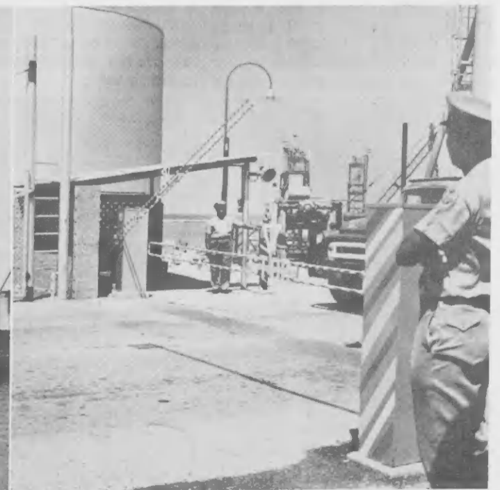
STRUCTURA PA brazanan di cargamento y e brazanan mes a worde erigi na No. 3 Finger Pier di Lago. E pier nobo ya ta muntra caba manera e lo ta ora ta cla. Mayor parti di tubería, robez, a worde instalá caba. E brazanan di cargamento ariba dos estructura, centro, ta pasando test. E proyecto a duna e empuje pa porta di control remoto, banda drechi na porta No. 2. E guardianan lo opera tambe portanan di e camina pa e pier.
